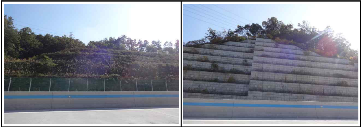
【그림 7.3.4】 보호/보강시설 전경
